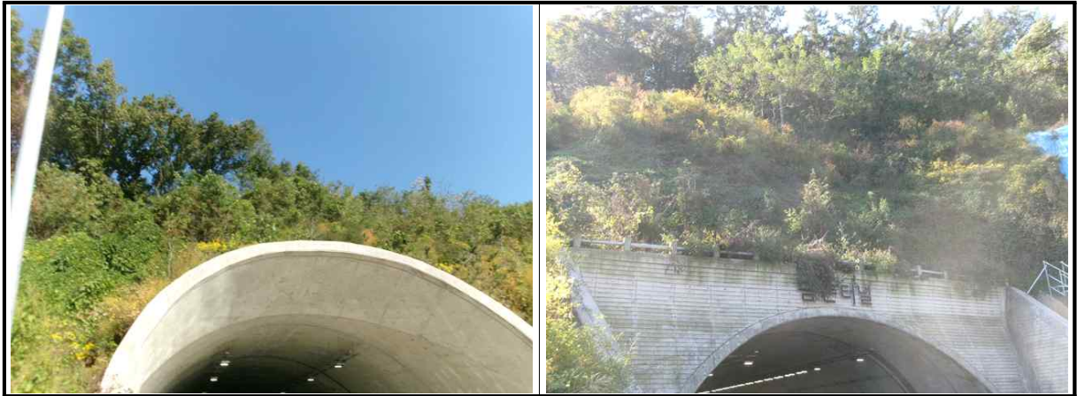
【사진 4.3.7】 사면 전경
