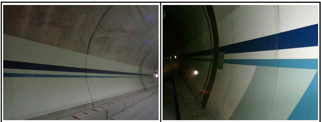
【사진 4.3.3】 라이닝 측벽부 전경
