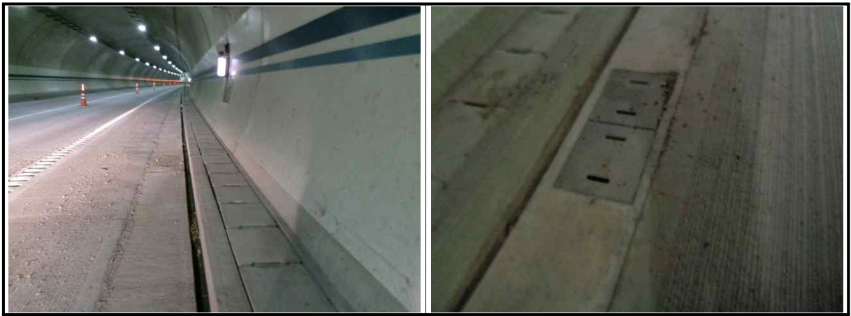
【사진 4.3.21】 공동구 및 배수시설 전경
