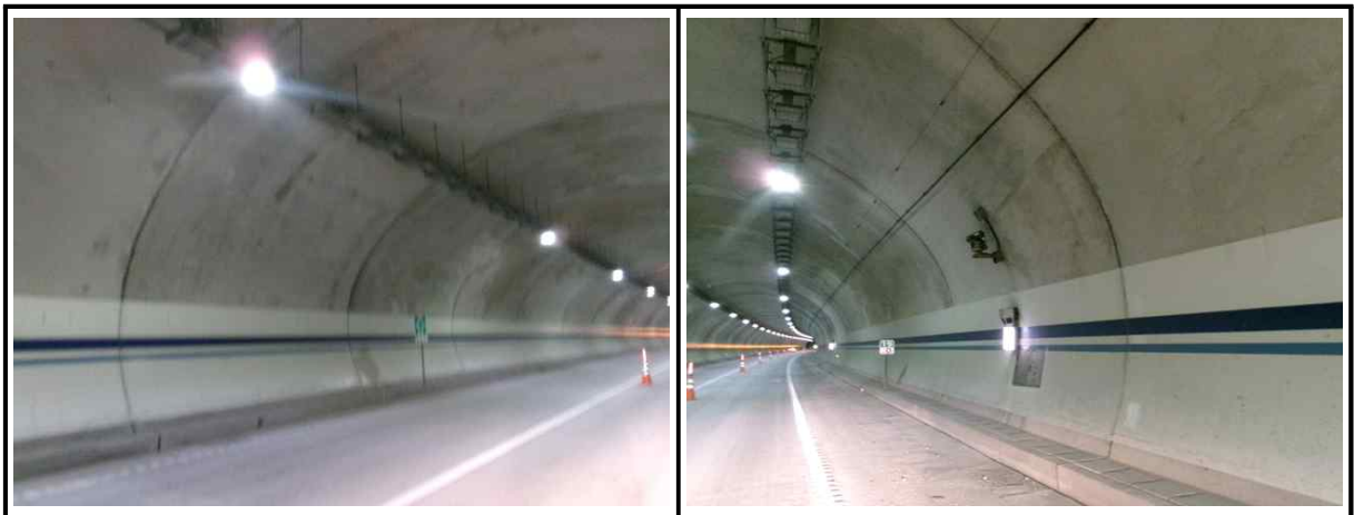
【사진 4.3.16】 라이닝 측벽부 전경
