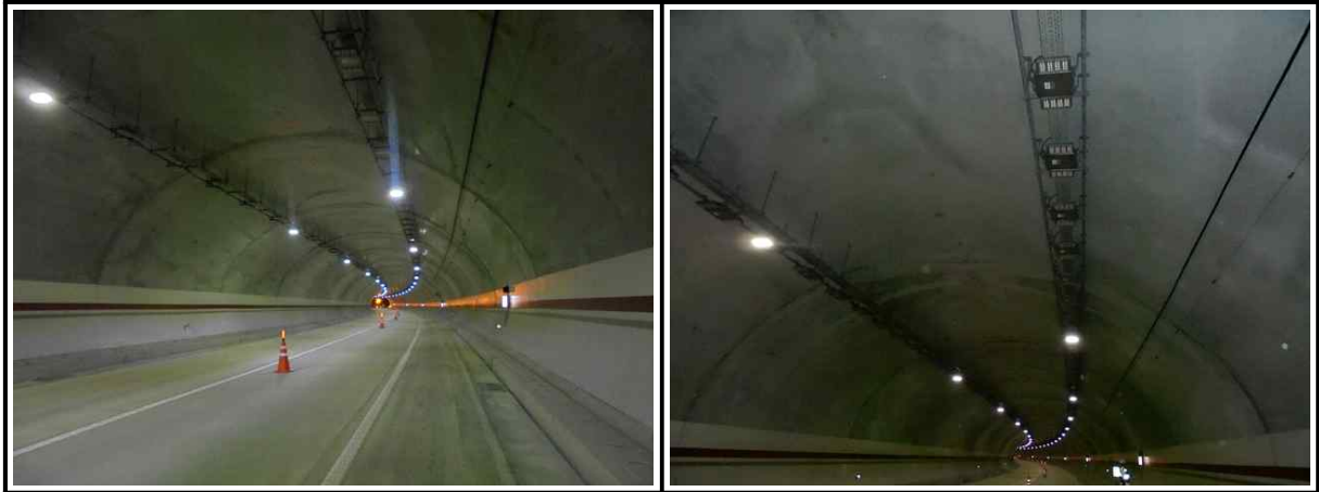
【사진 4.3.14】 라이닝 천단부 전경
