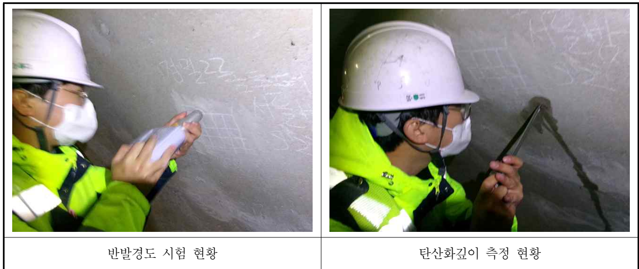
【사진 4.4.1】 콘크리트 내구성조사 현황
