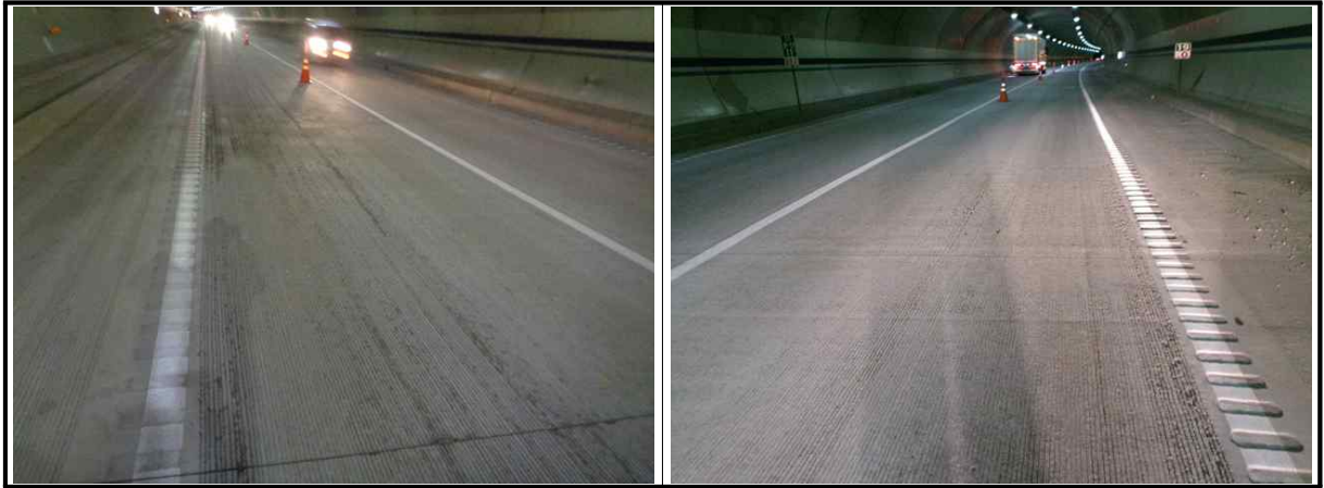
【사진 4.3.23】 포장부 전경
