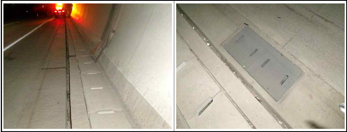
【사진 4.3.8】 공동구 및 배수시설 전경
