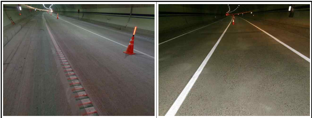
【사진 4.3.10】 포장부 전경
