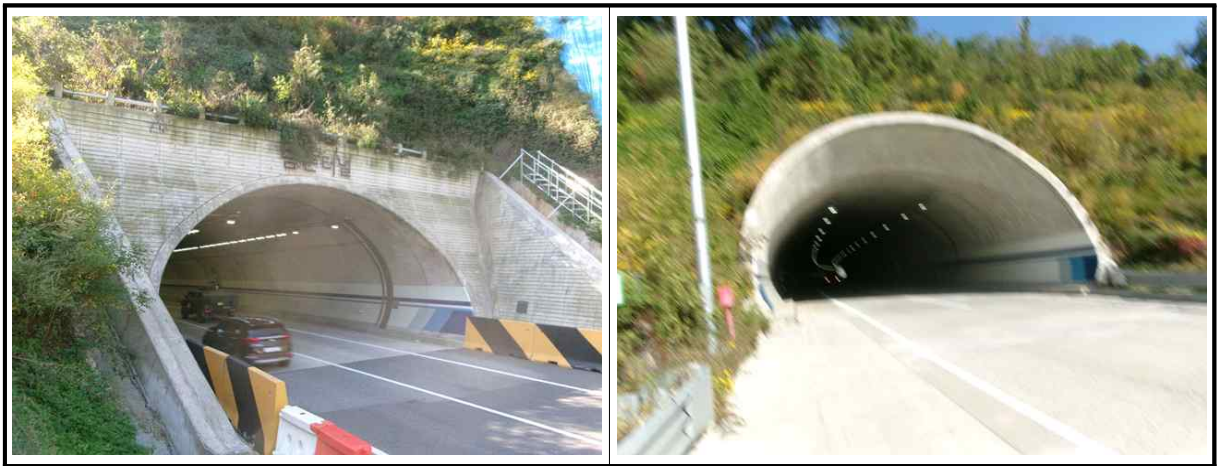
【사진 4.3.5】 갭문 전경
