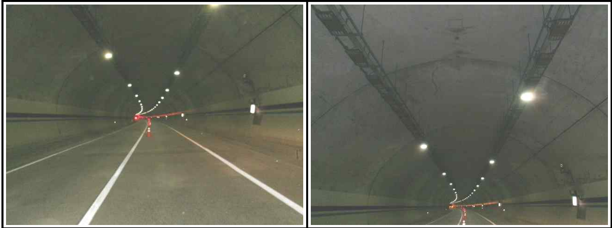
【사진 4.3.1】 라이닝 천단부 전경
