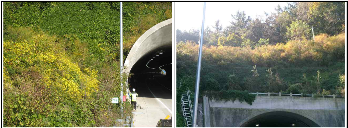
【사진 4.3.20】 사면 전경
